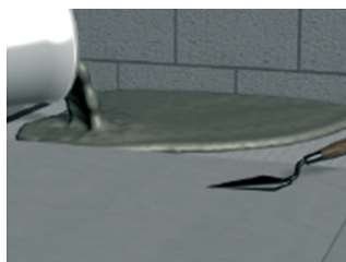
3. Wypełnij otwór zaprawą.
