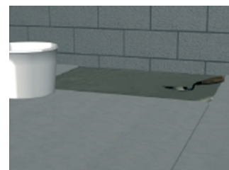
4. Wygładź powierzchnię uszczelnianego otworu.
