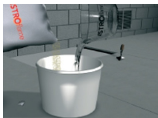
2. Dokładnie wymieszaj zaprawę z wodą, w odpowiednich proporcjach.
